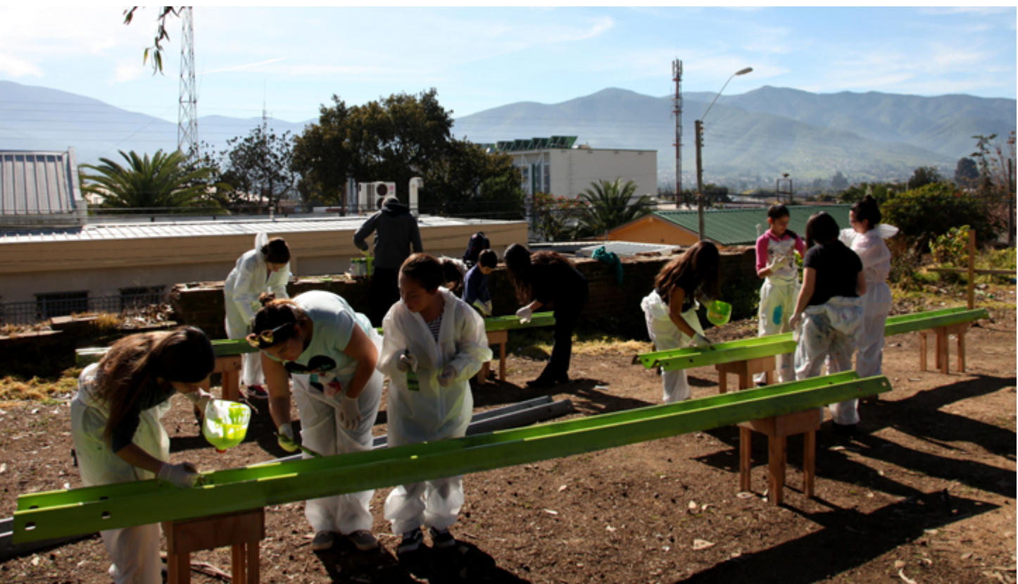
CONSTRUCCIÓN CASA EN EL ÁRBOL - CEECREA LA LIGUA © MINISTERIO DE LAS CULTURAS, LAS ARTES Y EL PATRIMONIO
