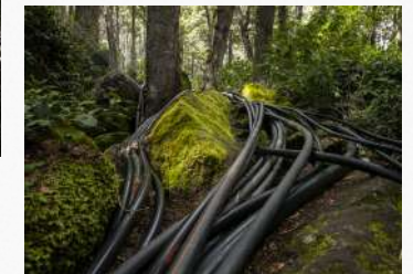
Nevados de Chillán, Valle las Trancas. Casi 800 arranques improvisados recogen agua de las vertientes y otros cursos de agua que vienen de la montaña. Son los que surten a los habitantes y a la gran oferta turística de este valle. Aún no existe una red de agua potable que no afecte el paisaje ni el sistema hídrico de aguas abajo del valle. Las mangueras de pvc negro de esta fotografía cruzan el bosque nativo subiendo hacia la cascada Velo de la Novia.
