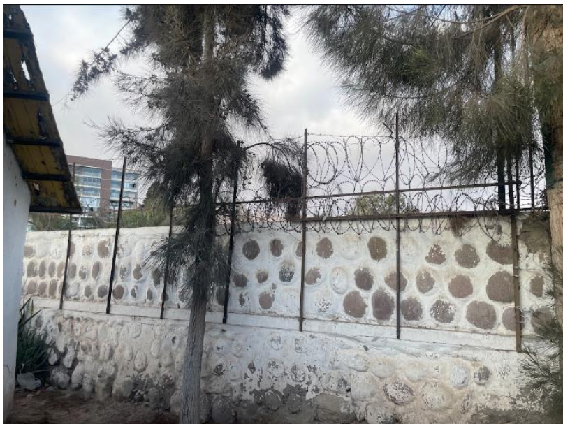
Muro de alambre con concertina
