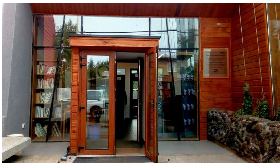
Imagen 10: Registro fotográfico fachada Biblioteca Municipal de Vilcún
