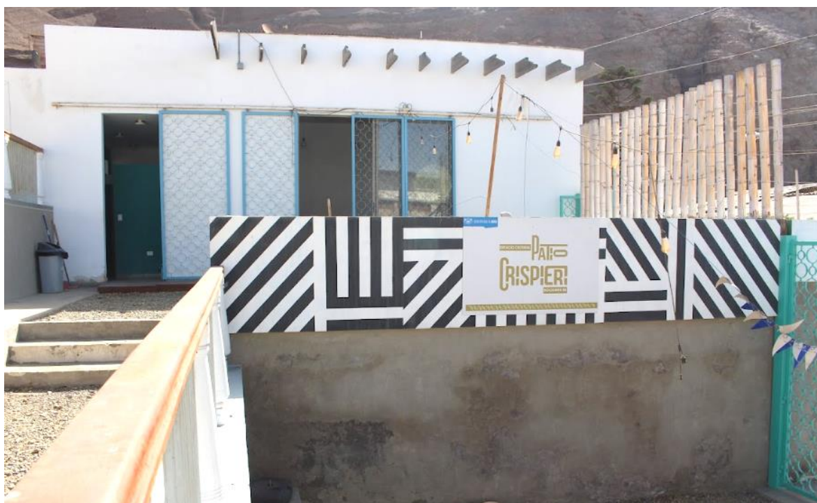
Imagen 3: Salón multiuso: equipamiento principal del patio Crispieri.
