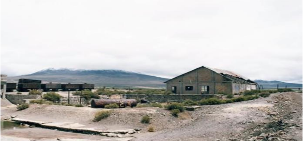
Foto 7 Villa Industrial, Campamento de Aguas Calientes y Montaña – andariveles.
