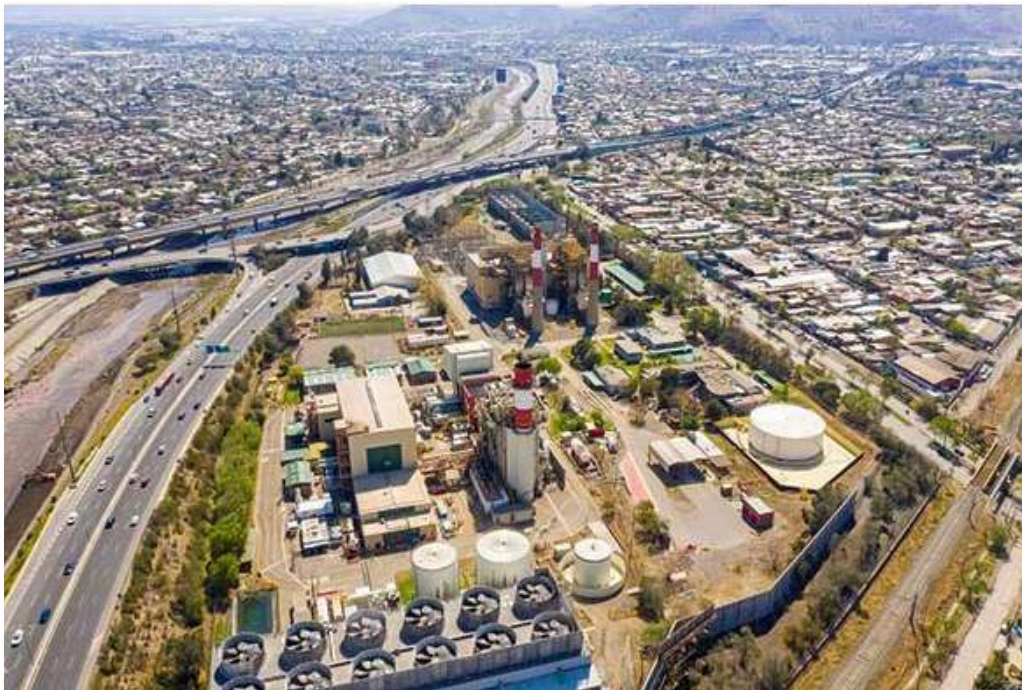
Imagen 7: Central Termoeléctrica Renca
