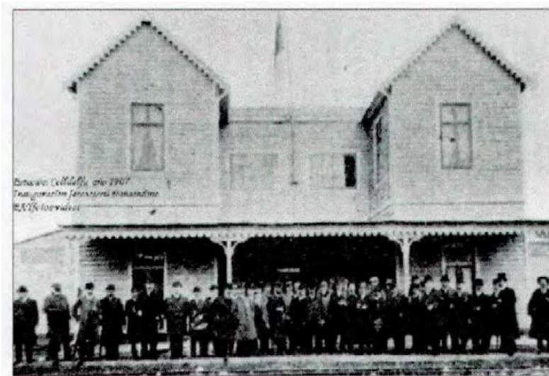
Imagen 5: Registro fotográfico histórico de la Estación Ferroviaria Collilelfu
