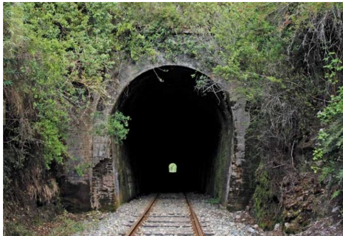
Imagen 8: Registro fotográfico Túnel Ferroviario
