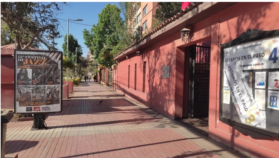
Imagen: Fachada Casa de la Cultura
