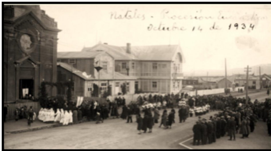
Imagen del edificio inaugurado
