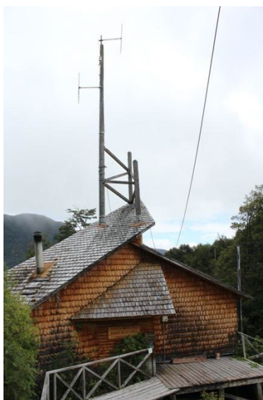
Edificio de la Radio Madipro de Tortel, 2021. (Fotografía: equipo FUSUPO).
