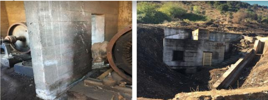
Fotografía N°10: Vista del estado actual de las instalaciones de “La Turbina” de Codao.
