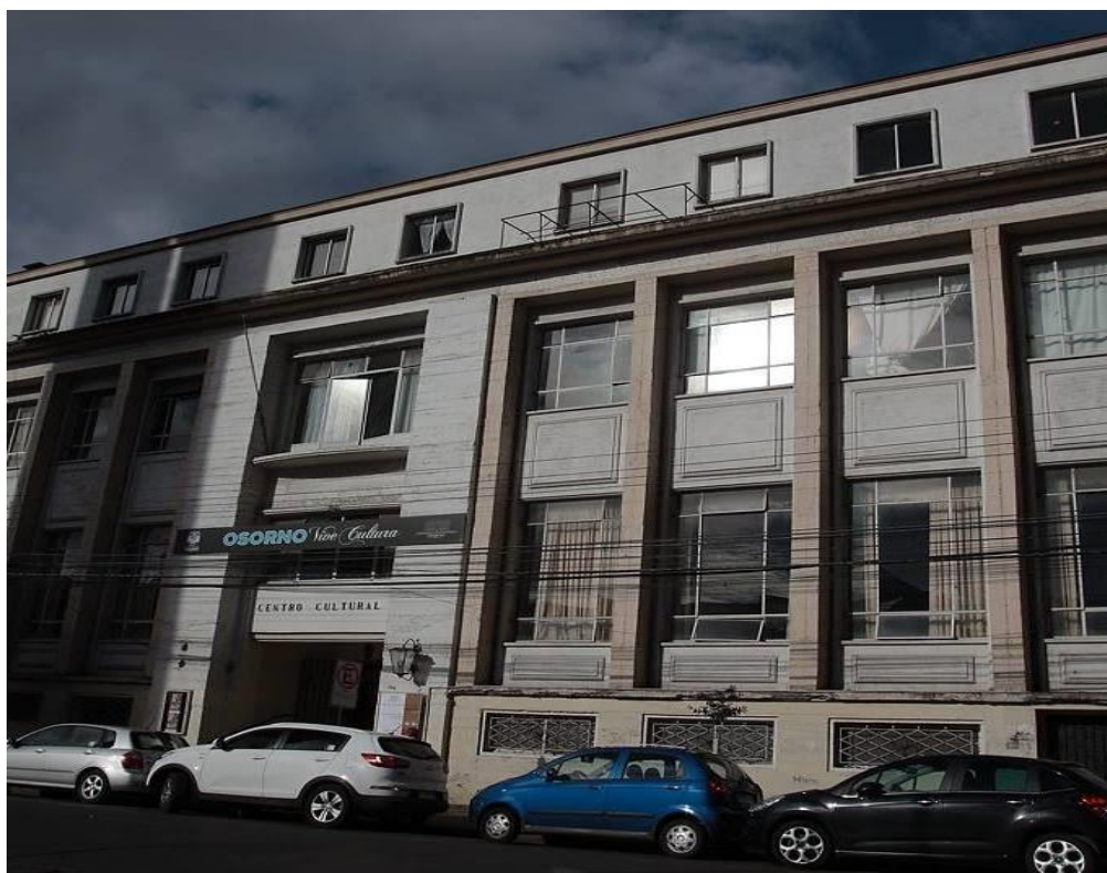
Foto 1: Fachada Centro Cultural de Osorno / Fotografía Jorge Viloria
