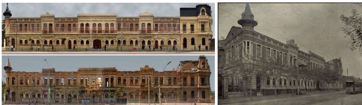
Fuente: Antes y después, restauración de fachada cervecería Ebner (Municipalidad de Independencia).
