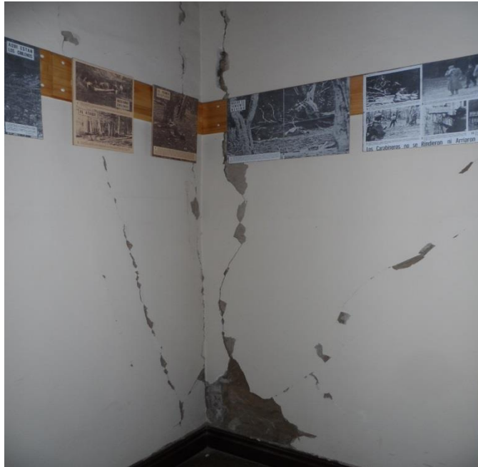
Muestra del nivel de daño estructural con el que cuenta el Museo
